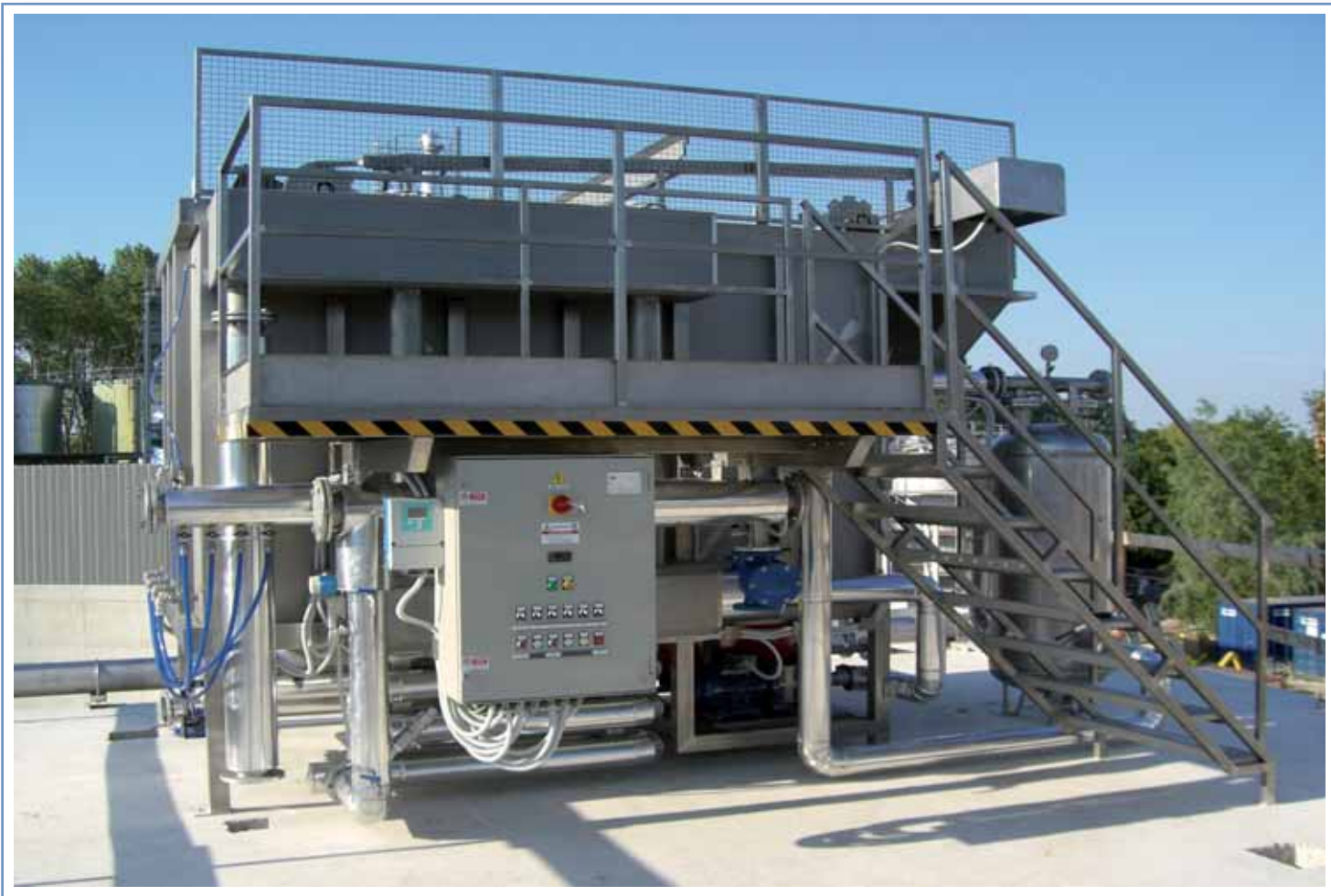
Impianto di Flottazione da 80 mc/h
